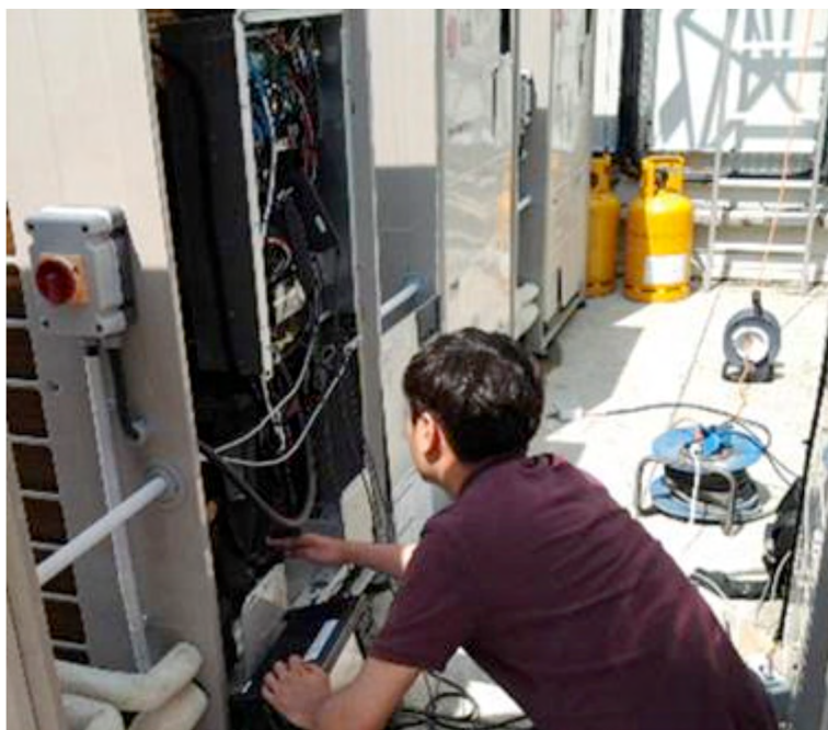
FIGURE 67 : Intervention sur une unité de climatisation DRV avec fluide R32
